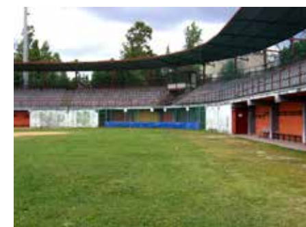
Immagini dello stato di fatto
